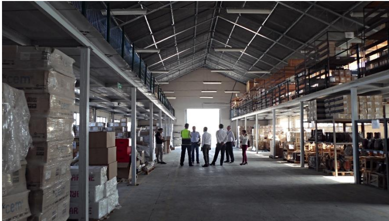
Eskişehir ilindeki Sultandere ana deposu
